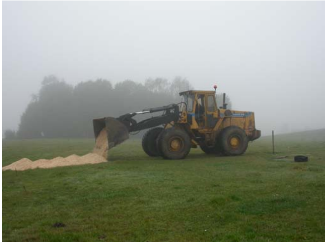
Udlægning af savsmuld
