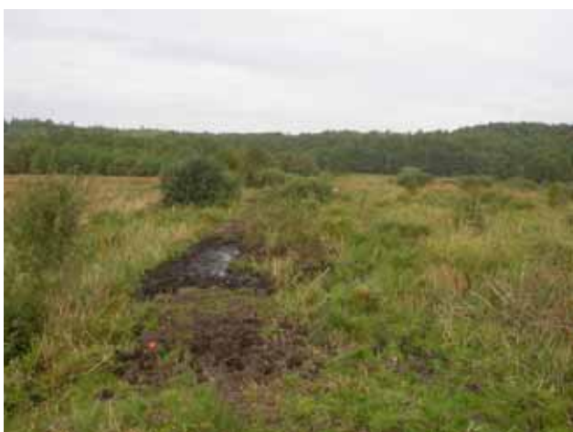
Optrådt passage i fugtigt område – behov for at vand bortledes.
